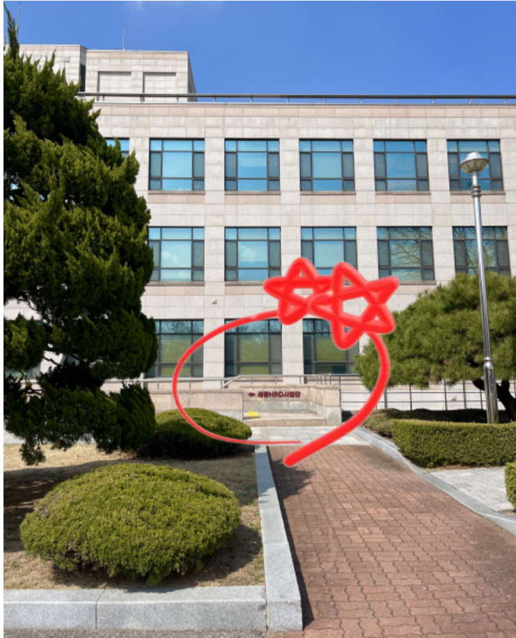
건물 정면 기준 우측 계단
